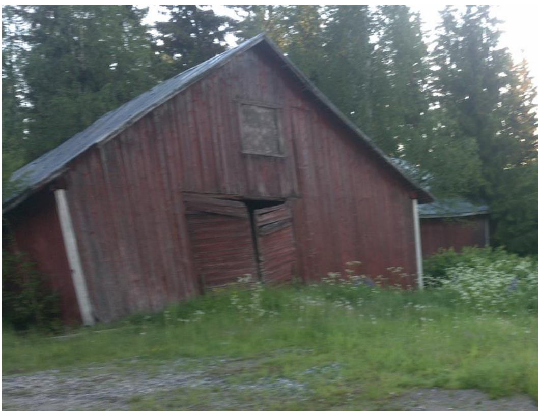
Kuva 14. Selvitysalueen eteläosassa sijaitseva lepakoiden lisääntymis- ja levähdyspaikaksi potentiaalinen vanha maatalousrakennus (Kohde A).
